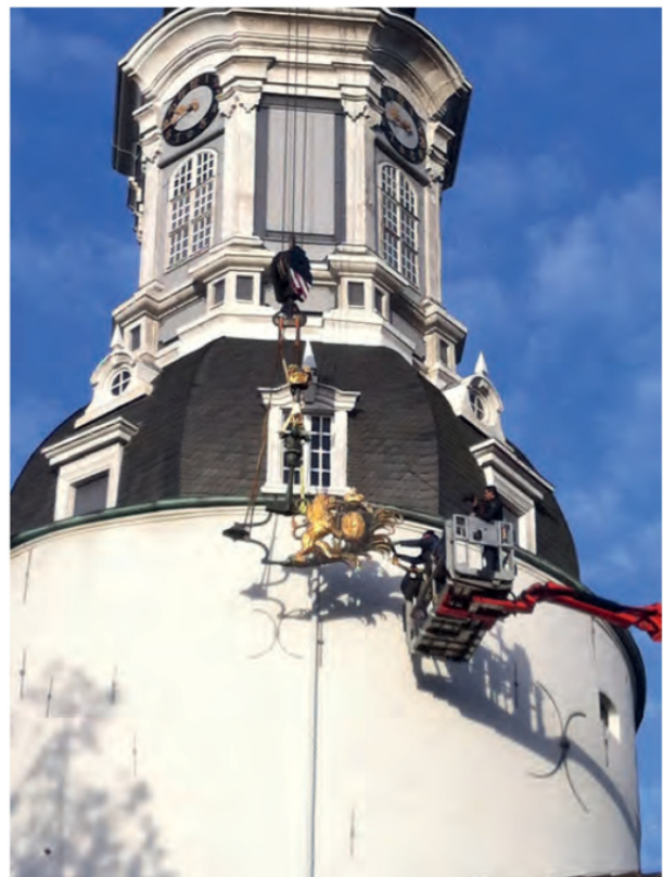
Abb. 1: Die Abnahme der Wetterfahne im Januar 2020 mit Kran und Arbeitsbühne (Foto: Schlossmuseum Jever).
