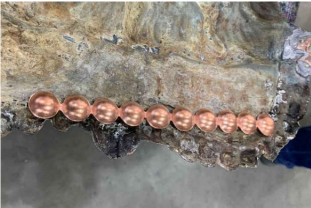
Abb. 3: Streifen des Perlkranzes. Um den Perlkranz an der Krone auszubessern, wurde aus Kupferblechstreifen mit dem Rundkopfhämmer eine Reihe von Halbkugeln eingeschlagen. (Foto: HABER & BRANDNER GMBH)
