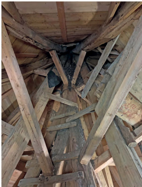
Abb. 2: Blick in die Spitze der sogenannten Zwiebelhaube. Man erkennt die vier eisernen Federn als Arretierung der Fahne und zahlreiche Handwerker-Inschriften im hölzernen Gebälk. (Foto: Schlossmuseum Jever 2020).
