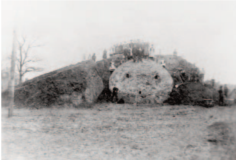
Abb. 12: Abriß des Pulverturms der historischen Festungsanlage, 1900. (Fotoarchiv Schloßmuseum Jever)
